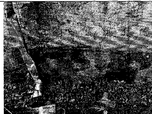
Фото 22, 23. Локальные разрушения защитного штукатурного слоя стены. Вызван промерзанием насыщенной влагой кладки и дальнейшим её разрушением, а также внешними механическими воздействиями (включая атмосферные осадки и влияние паводка).
