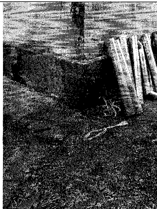
Фото 5, 6. Локальные участки трещин, следов растительности, проседания, неплотного примыкания отмостки к цоколю, что способствует замачиванию фундамента здания, а также подвального помещения и не соответствует требованиям п. 6.26 СП 82.13330.2016 «Благоустройство территорий».
