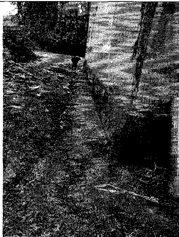
Фото 5, 6. Локальные участки трещин, следов растительности, проседания, неплотного примыкания отмостки к цоколю, что способствует замачиванию фундамента здания, а также подвального помещения и не соответствует требованиям п. 6.26 СП 82.13330.2016 «Благоустройство территорий».
