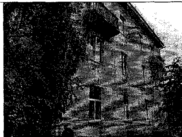
Фото 22, 23. Локальные разрушения защитного штукатурного слоя стены. Вызван промерзанием насыщенной влагой кладки и дальнейшим её разрушением, а также внешними механическими воздействиями (включая атмосферные осадки и влияние паводка).
