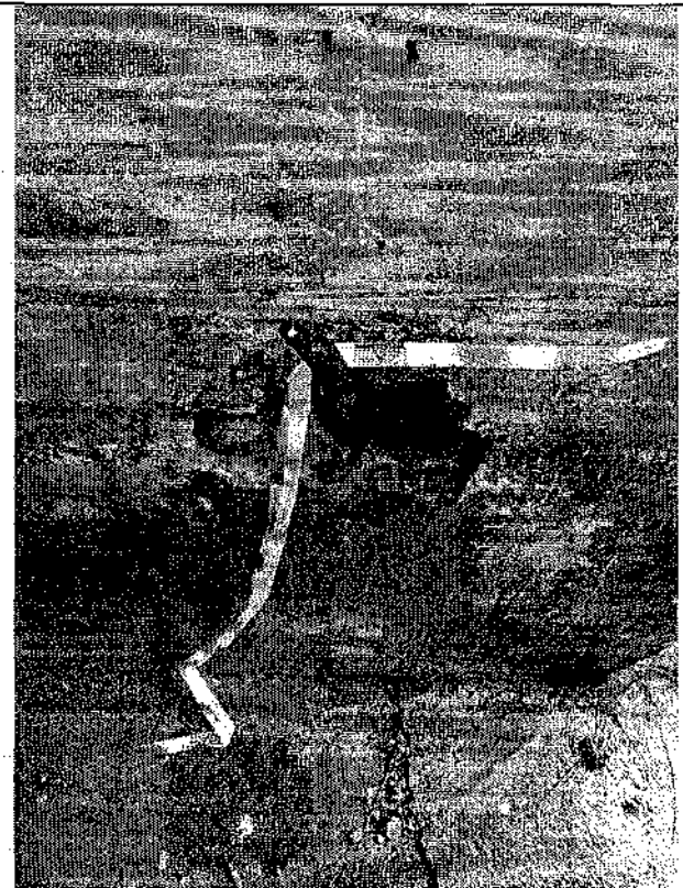
Фото 15, 16, 17, 18. Вымывание отделочного покрытия (цементной штукатурки) у
