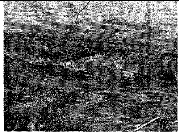
Фото 11, 12, 13, 14. Локальные разрушения защитного штукатурного слоя стены под окнами 1 этажа здания. Дефект эксплуатационного характера. Вызван промерзанием насыщенной влагой кладки и дальнейшим её разрушением, а также внешними механическими воздействиями (включая атмосферные осадки).
