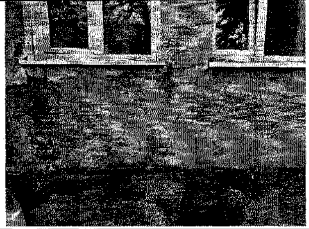
Фото 11, 12, 13, 14. Локальные разрушения защитного штукатурного слоя стены под окнами 1 этажа здания. Дефект эксплуатационного характера. Вызван промерзанием насыщенной влагой кладки и дальнейшим её разрушением, а также внешними механическими воздействиями (включая атмосферные осадки).
